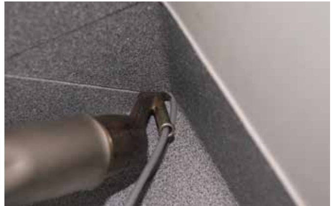
12. Verschweißen Sie die Innenecke.
