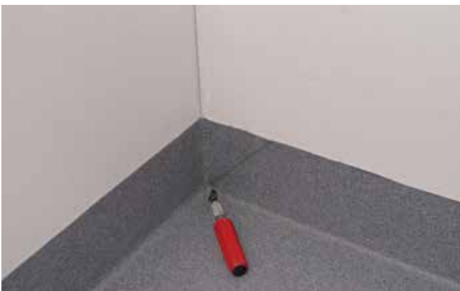
13. Stoßen Sie die Schweißschnur belagsbündig ab.
