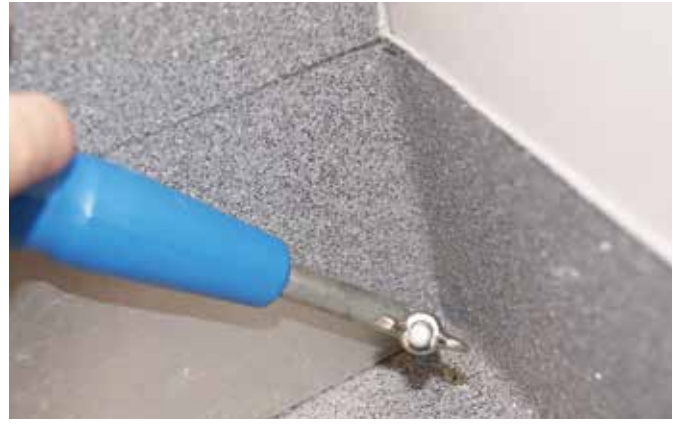
10. Fräsen Sie den Bodenbelag an der Innenecke ein und verwenden Sie dabei zur Führung die Dreiecksschablone.
