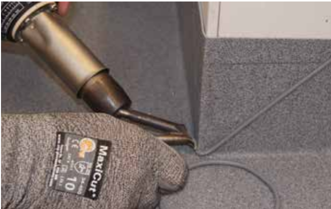
11. Verschweißen Sie die Außenecke
