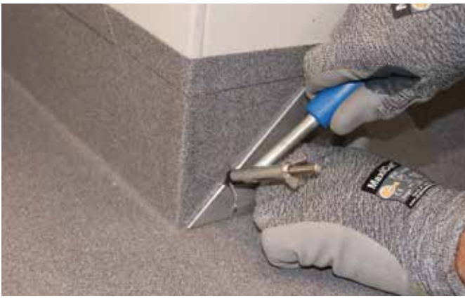
9. Fräsen Sie den Bodenbelag an der Außenecke ein und verwenden Sie dabei zur Führung die Dreiecksschablone.
