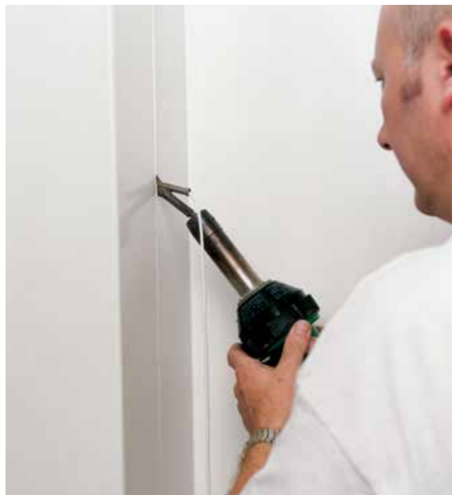
Instalación soldada térmicamente
