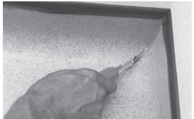
2. Recorte el cordón sobrante con la cuchilla trazadora redonda.
